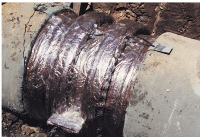
Le Poly-Ply est un revêtement en plastique multicouche. Il contribue à maintenir une séparation entre le bande et le sol.
